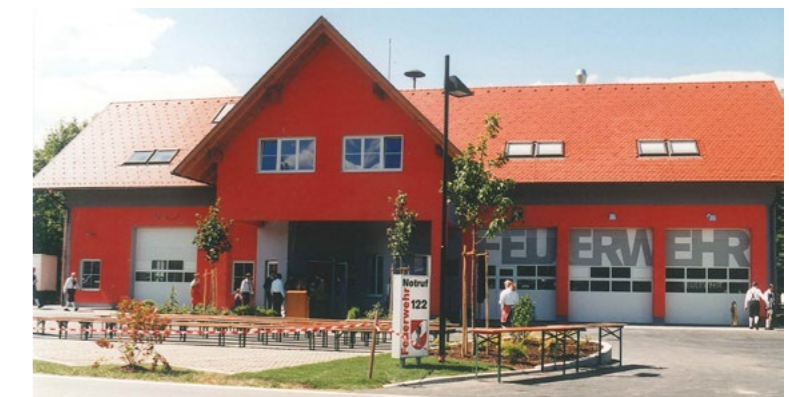
1997 bis 1999 – Neubau des Rüsthauses an einem neuen Standort an der B69 (Mehrzweckgebäude der Gemeinde Pitschgau), (Abb. 9.62, Seite 136)
