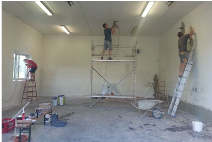
Abb. 11.40: Der Umbau erfolgte wieder komplett in Eigenleistung
