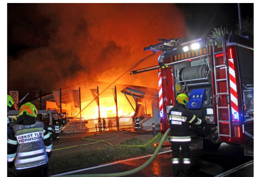
Abb. 11.92 bis 11.93: Rund 12.000 m 2 der Hallen wurden ein Raub der Flammen
