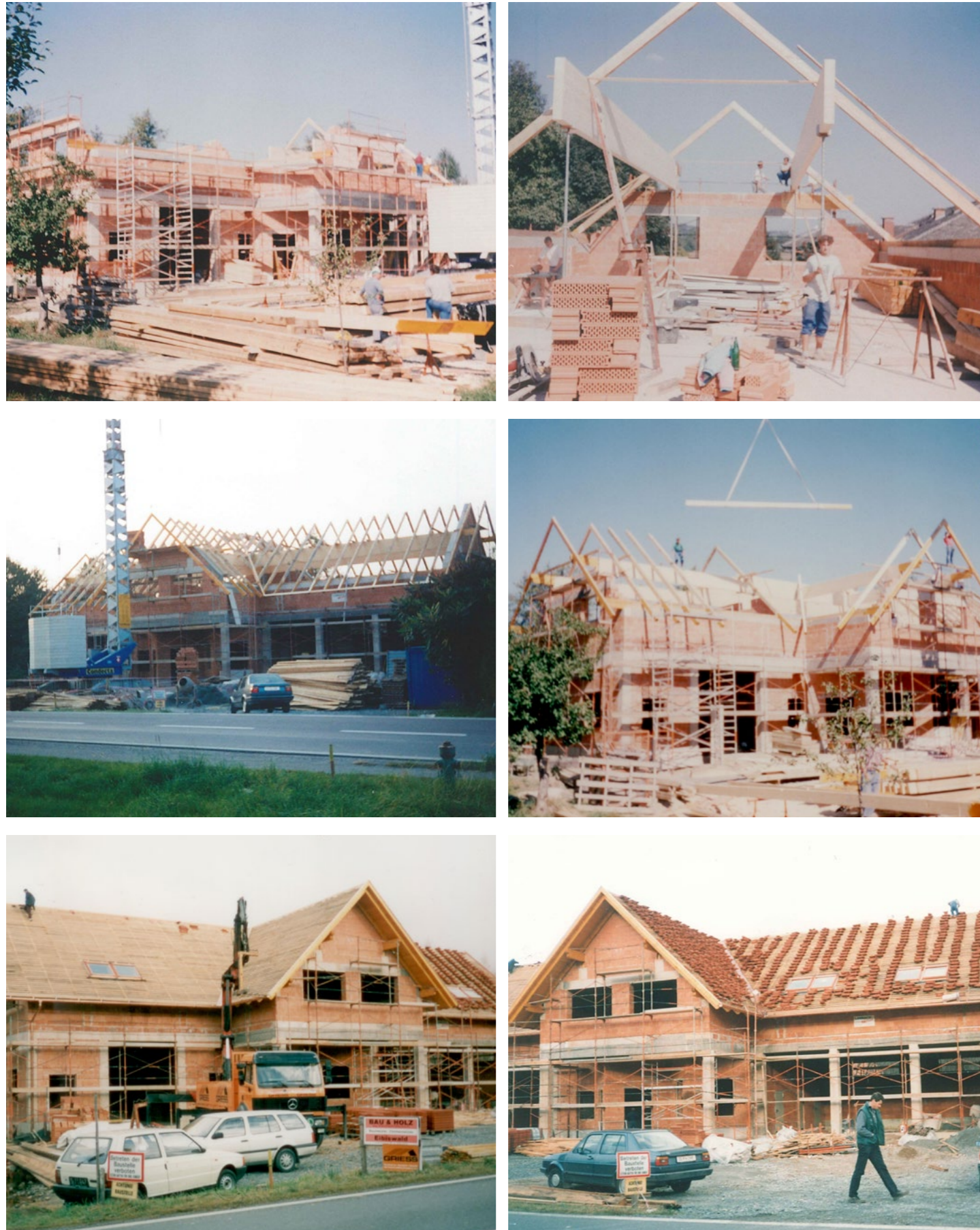
Abb. 9.35 bis 9.46: Bau des neuen Rüsthauses in Hörmsdorf in den Jahren 1997 und 1998
