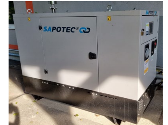
2022: Installation eines fixen Notstromaggregates (Abb. 11.106, Seite 203)
