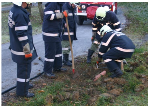
Abb. 10.45: Eine Katze war im Regenabflussrohr steckengeblieben
