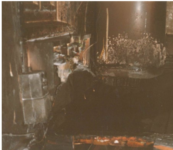
Abb. 9.6: Ergebnis eines Zimmerbrandes in Feisternitz am 11.11.
