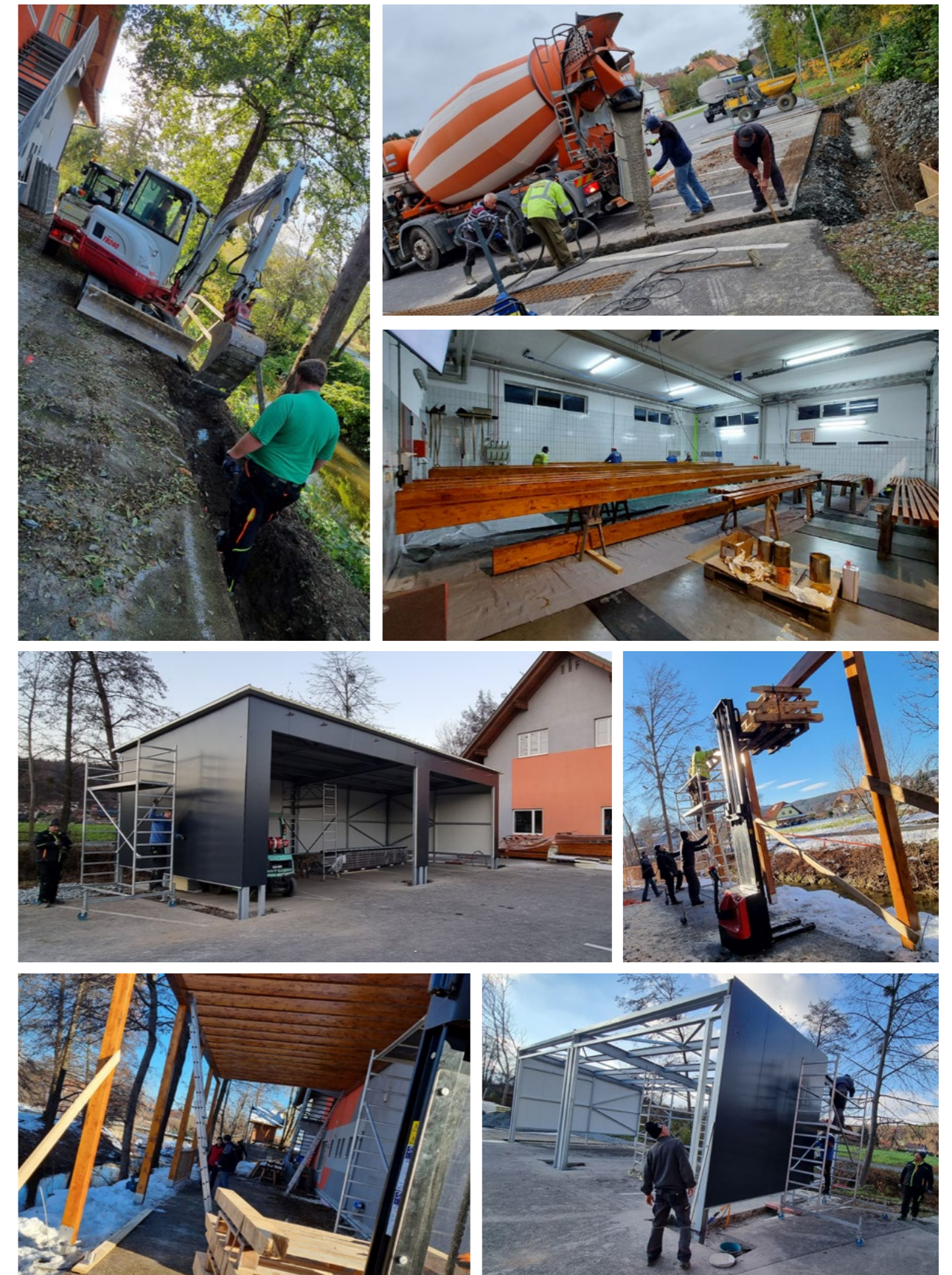
Abb. 11.95 bis 11.101: Die Arbeiten wurden größtenteils in Eigenleistung durchgeführt, vom ersten Baggeraushub, über das Aufstellen der Halle, dem Streichen des Holzes, bis zum Errichten der Überdachung. Wo möglich wurden zivile Helfer eingesetzt, nur wo erforderlich wurden Leistungen zugekauft.
