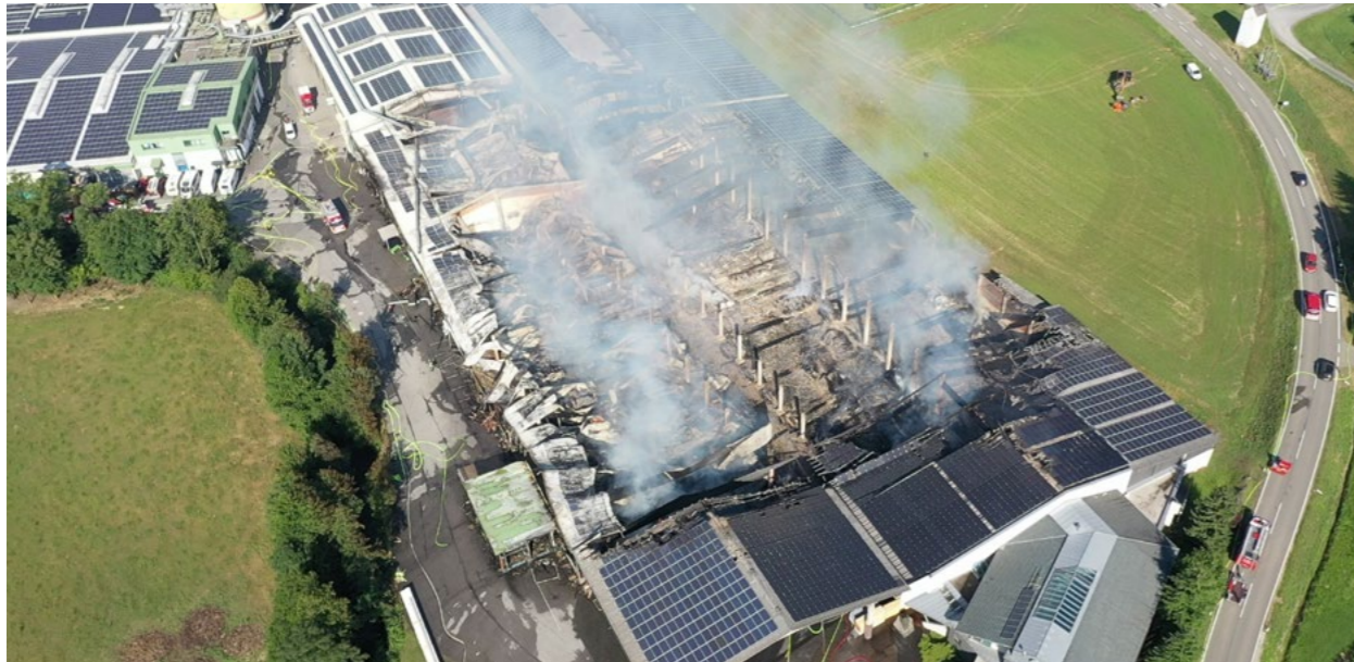
Abb. 11.94: Rund 12.000 m 2 der Hallen wurden ein Raub der Flammen
