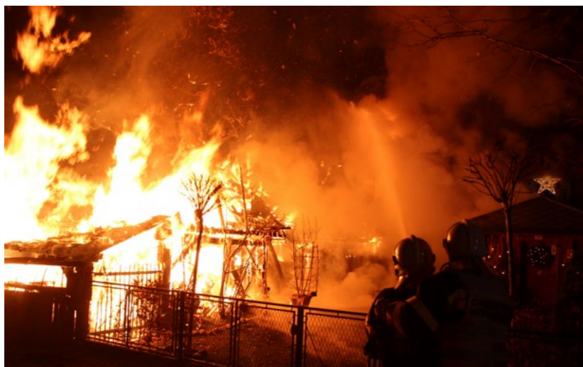
Abb. 11.47: Wohn- und Wirtschaftsgebäudebrand in Feisternitz, beim Eintreffen der Einsatzkräfte standen beide Gebäude bereits in Vollbrand
