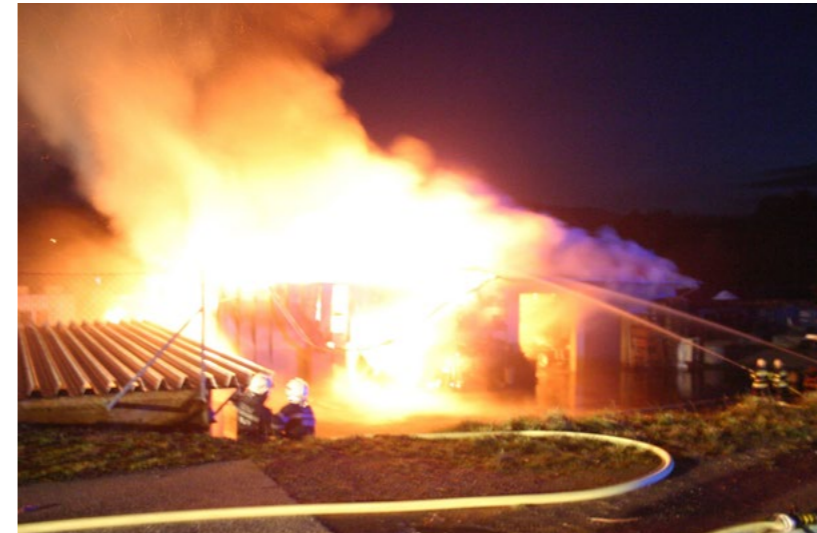
Abb. 11.20: Das Feuer am 27.11. zerstörte die komplette Lagerhalle
