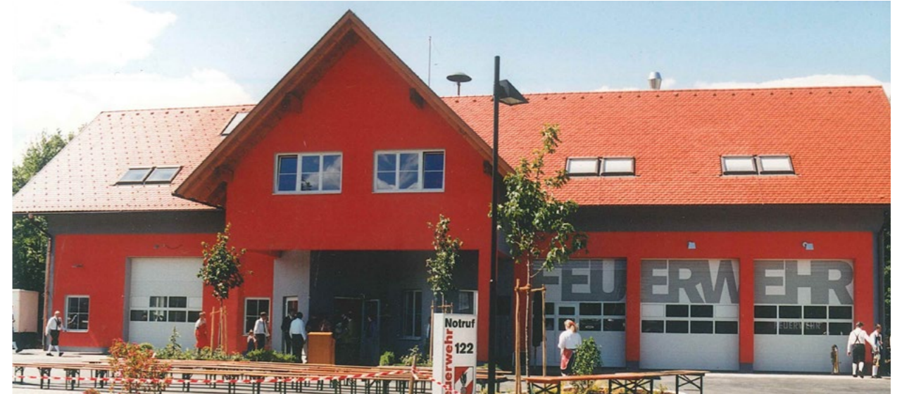
Abb. 9.62: Das neue Mehrzweckgebäude kurz vor der offiziellen Eröffnung
