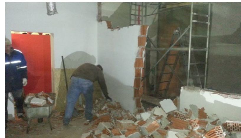
Abb. 11.55 bis 11.57: Die Arbeiten wurden wie üblich größtenteils in Eigenleistung und mit zivilen Helfern durchgeführt
