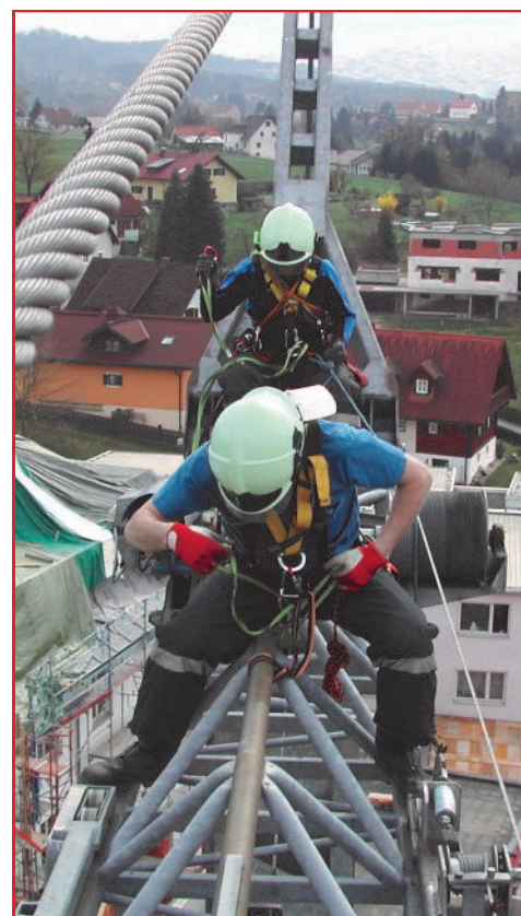
Übung auf einem Baustellenkran in Eibiswald am 20.04.
