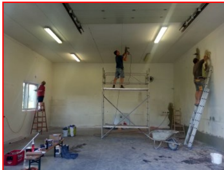
Kurzfristig wurden die Umbauarbeiten in Angriff genommen
