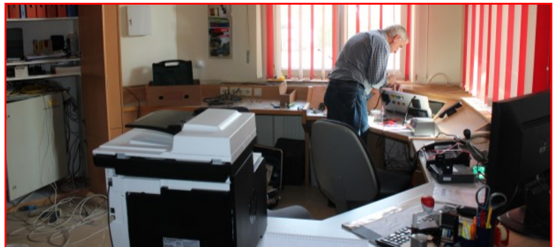
Einbau des neuen zentralen Bedienpults im Rüsthaus am 22.10.2015
