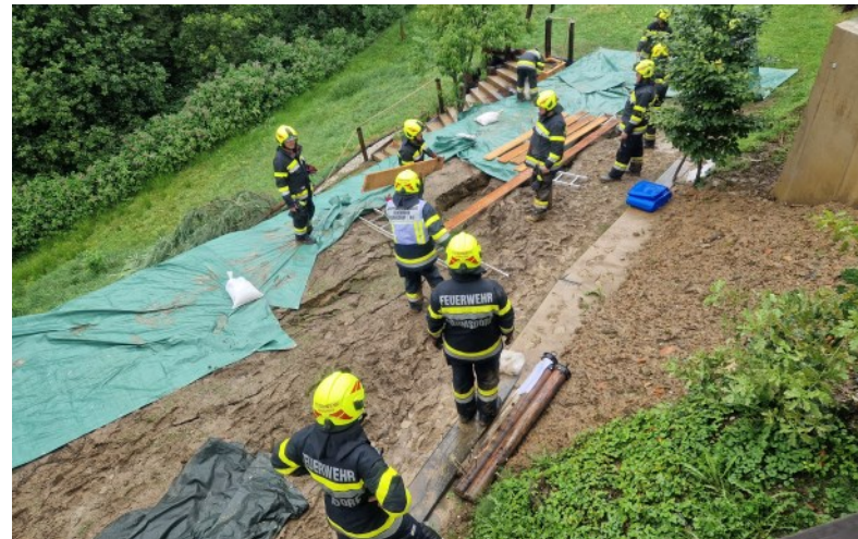
Die Sicherung von Hangrutschungen war eine vorrangige Aufgabe der Feuerwehr
