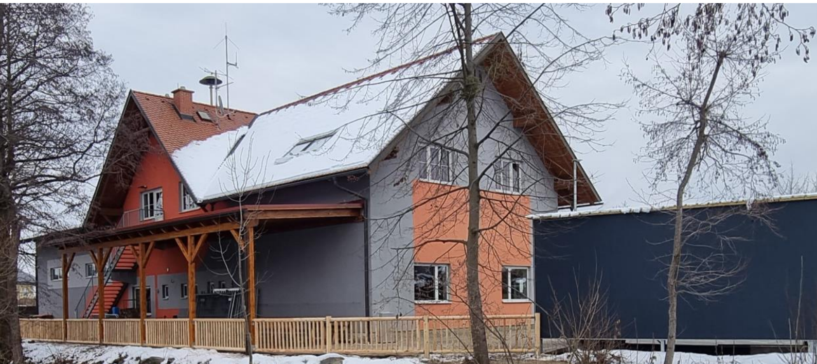
Links die an das bestehende Rüsthaus angebaute Überdachung und der neu errichtete Zaun am Ufer der Saggau, rechts
