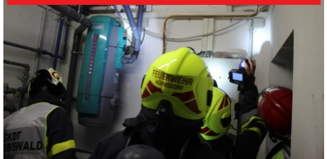
Nach längerer Suche wurde ein defekter Elektromotor der Zentralstaubsaugeranlage als Ursache der Rauchentwicklung identifiziert
